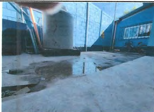
Foto 3: Mejoramiento de Tinaco.
